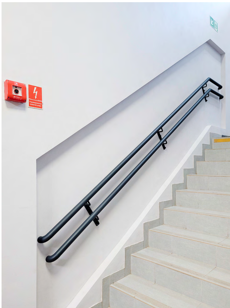
Ilustracja 67. Przykład poręczy zamontowanej we wnęce na ścianie (budynek istniejący), fot. Katarzyna Guratowska
