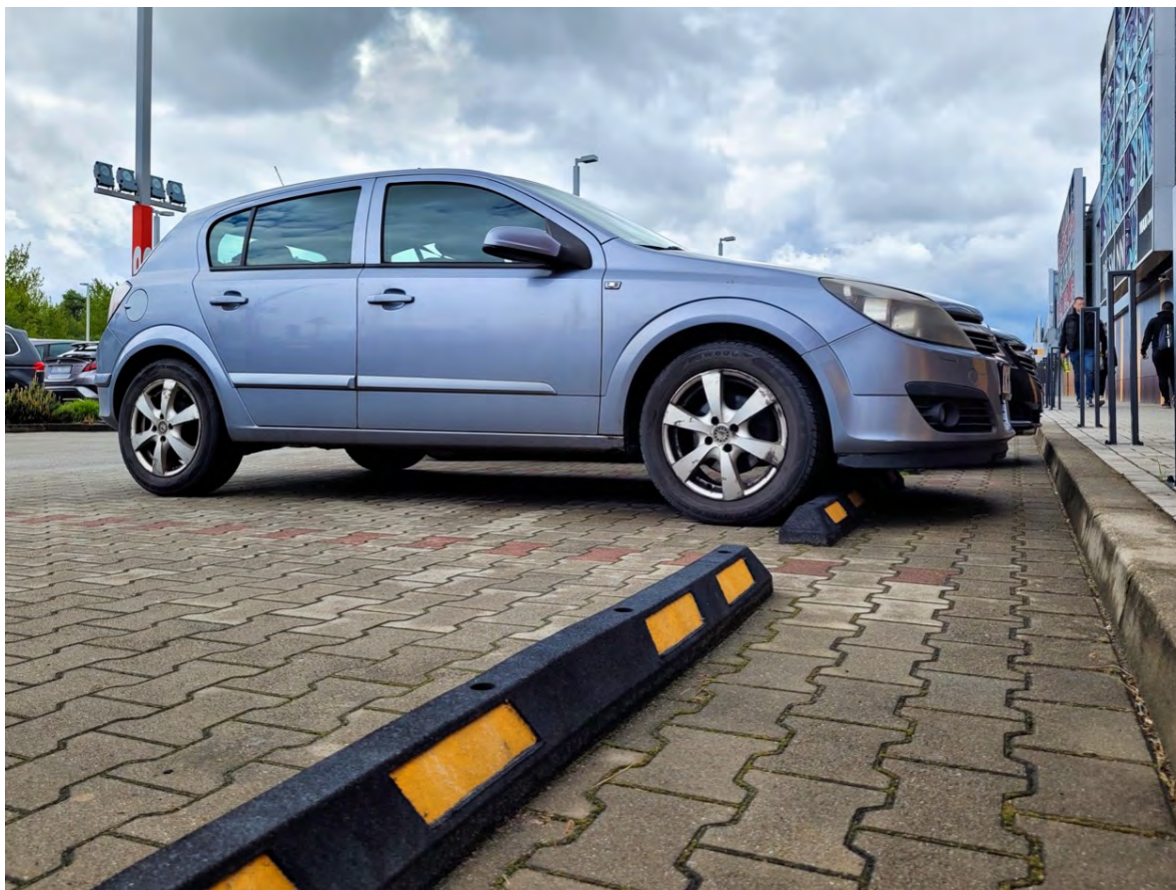
Ilustracja 22. Przykład ogranicznika (separatora) zapobiegającego zbyt bliskiemu parkowaniu przy ciągach pieszych, fot. Katarzyna Guratowska
