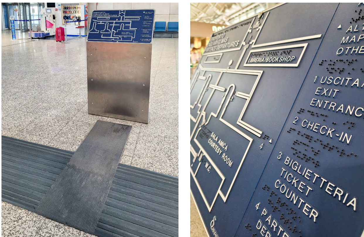
Ilustracja 15. Przykład podkreślenia lokalizacji planu tyflograficznego za pomocą pola informacji typu C1, umieszczonego asymetrycznie względem ścieżki kierunkowej, fot. Katarzyna Guratowska
