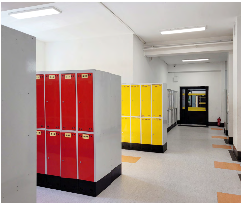
Ilustracja 70. Przykład szatni z prawidłowym zastosowaniem pasów kontrastujących na styku podłogi i płaszczyzn pionowych i kolorystycznym oznakowaniem wejść do boksów, fot. Katarzyna Guratowska
