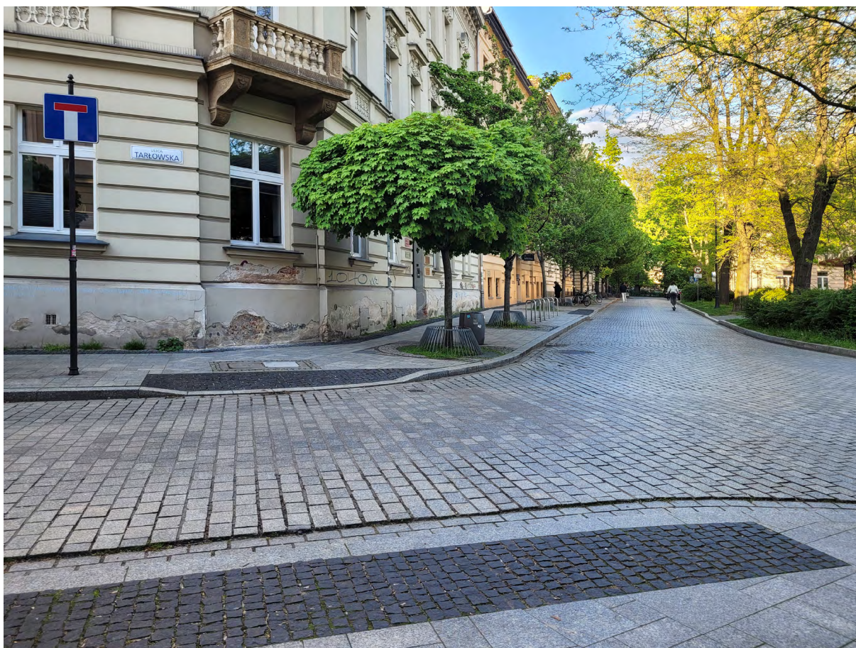
Ilustracja 14. Przykład zastosowania kostki łupanej do oznaczenia przejścia przez jezdnię znajdującego się w strefie ochrony konserwatorskiej, fot. Katarzyna Guratowska
